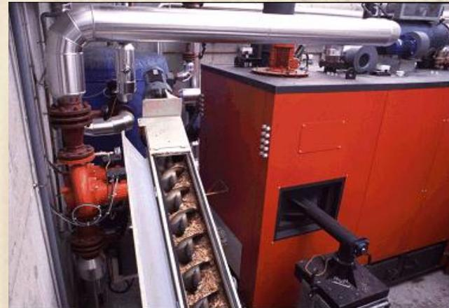
Une chaufferie doit être alimentée en biomasse calibrée, avec un flux régulé et un stock suffisant
