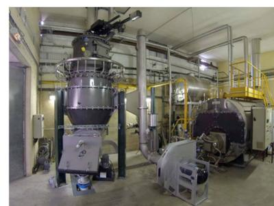
Il s'agit du remplacement d'un brûleur à gaz naturel de 2 MW sur chaudière vapeur 15 bars par un gazéifieur et un brûleur biomasse bi-combustible (syngaz et gaz naturel) de 2 MW.
